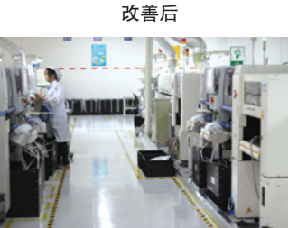
SMT线地面改善为防静电地面，现场连垃圾箱均有定位、标识
